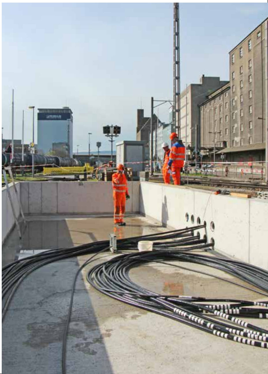
Fundament des neuen Stellwerks im Hafen Kleinhüningen
