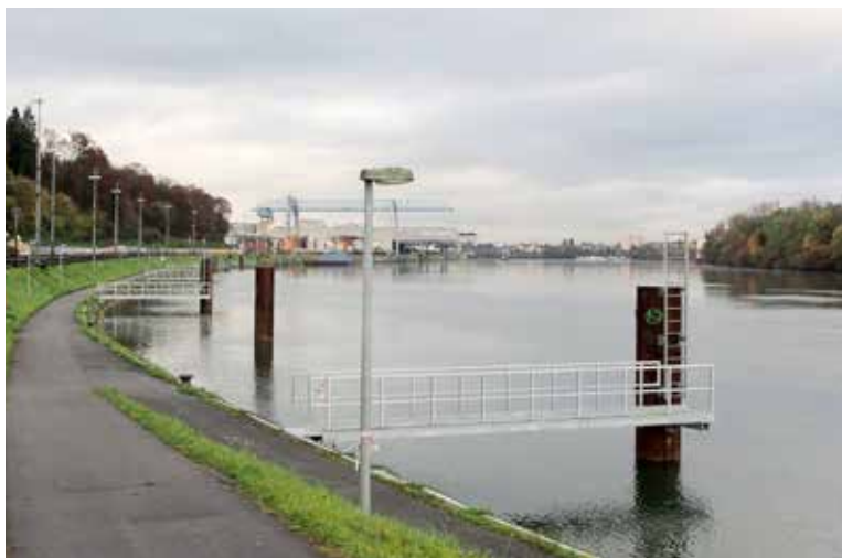
Die neuen Anlegestellen im Auhafen Muttenz
