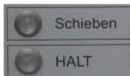
Taste «Halt» drücken -> Ablaufsignale fallen bzw. bleiben auf Halt.
